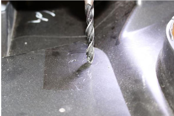
Bild 3: Bohrer an vorgesehener Markierung
