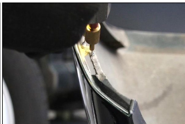
Abbildung 7: Einschweißen des Stahldrahtes
