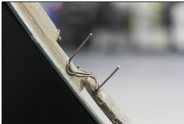
Abbildung 8: Stahl Draht-Klammer zur Stabilisierung
