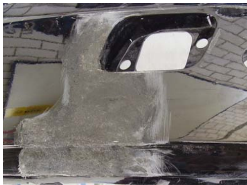
Abbildung 9: Verschweißte Reparaturstelle
